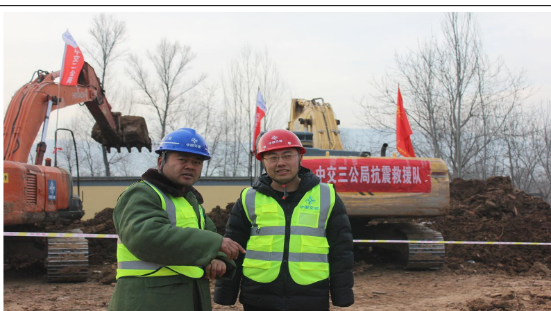
三公局大清2标项目负责人、党员郭亚鹏和项目安全总监郑志恒在地震发生后，全程参与到金田村的搜救工作中，他们始终坚守在救灾前线，用自己的实际行动诠释着责任，这是他们站在挖掘机面前讨论救援工作开展的画面。
