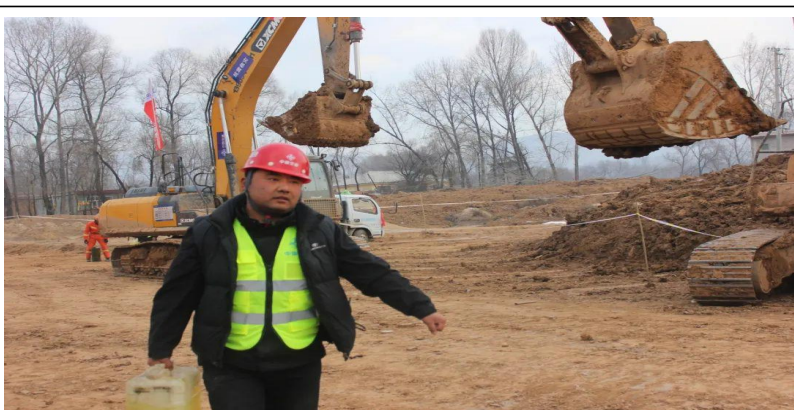
由于地震造成的“砂涌”，给挖掘机加油带来不便，大清2标项目物资部副部长周斌在受灾现场冒着随时陷入泥泞的危险，徒步奔走，给挖机运送柴油。
