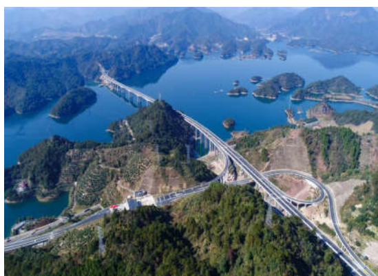
隧道、生坑桥、生坑隧道、坪山互通立交桥，路线长度8.502km，桥隧比78%。千黄高速的开通，标
